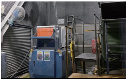
粉碎間鋪設隔音棉降低噪音
